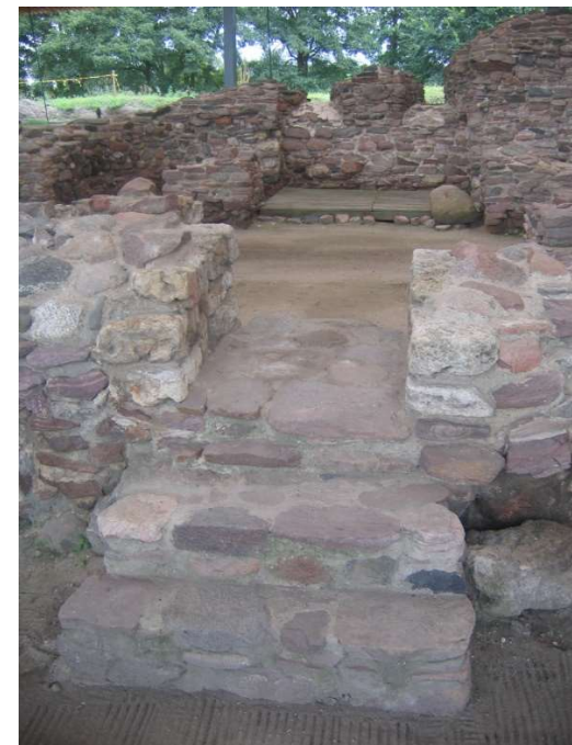
Przypuszczalne wejście do kaplicy od północy oblicowane martwicą wapienną
